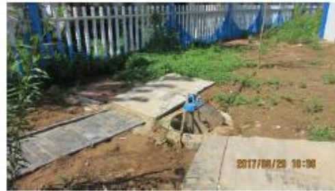
(厂区污水总排口)
