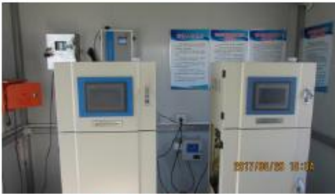
(废水在线监测室)
